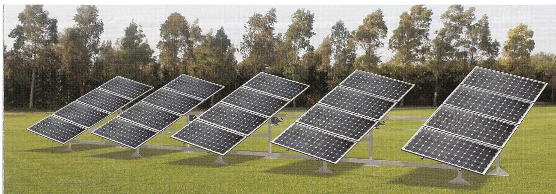
I sistemi biassiali sono, invece, caratterizzati da una "doppia" rotazione (ovvero una rotazione su due assi), che consente loro di seguire il movimento solare sia in relazione sia alle variazioni dell'angolo azimutale (direzione di provenienza) che in relazione alle variazioni dell'angolo di incidenza (inclinazione solare).
